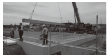
3本目の橋桁を橋台に架設している様子▶
