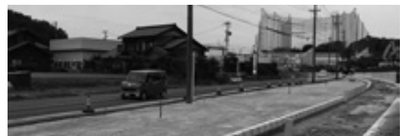
▲写真① 道路拡幅工事(町施工)
