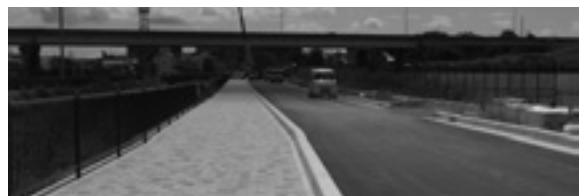
▲写真② 歩道の整備状況(組合施工)
