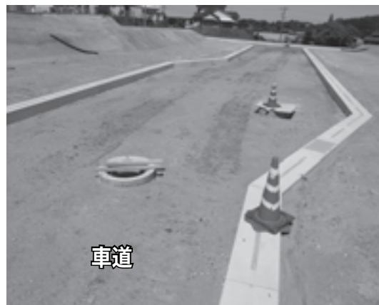
▲生活道路 施工中の様子
