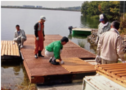
2005年のスカル用桟橋改修の様子
