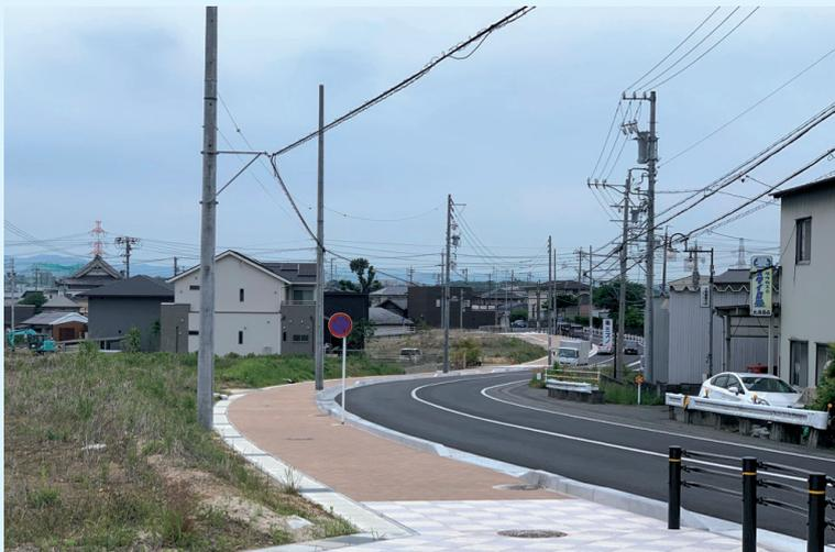
※「インターロッキングブロック」とは、舗装用コンクリートブロックを規則的に敷き並べ、ブロック相互のかみ合わせにより荷重分散を図る舗装方法です。色合いなどの工夫により、周辺環境に調和した舗装面を形成することができます。
