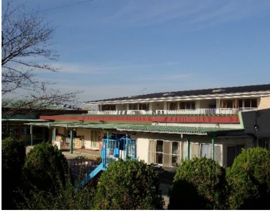
1-1 中部保育園南棟
