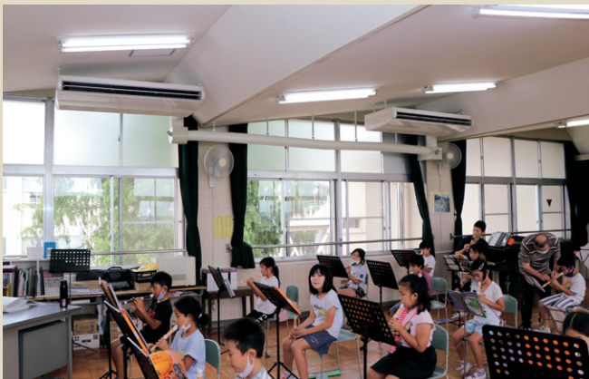
普通教室に続き、小中学校の特別教室にエアコンを設置
