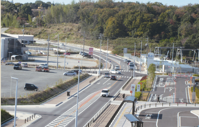
セントラル開発区域の道路などを整備
