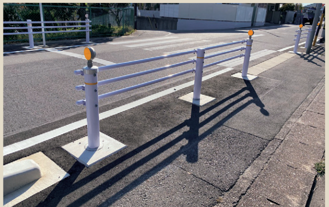
通学路などにガードレールを設置 (撮影場所:高嶺小学校前)
