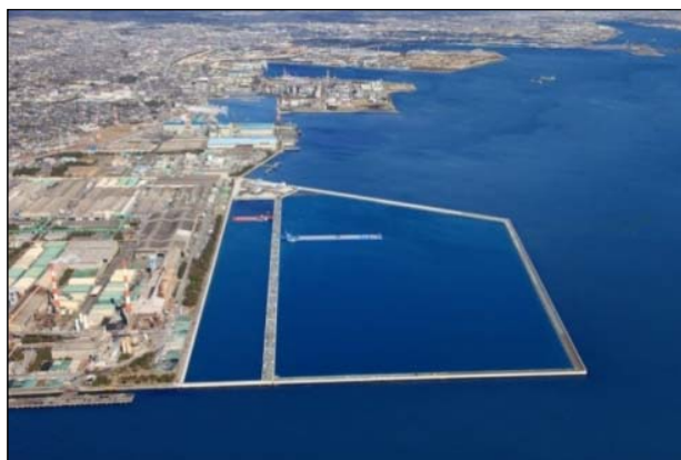
衣浦港3号地廃棄物最終処分場
