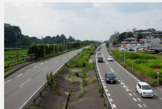
【(都)国道 153 号バイパス線】
