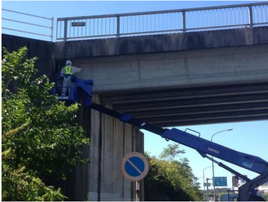
写真-4.1 専門業者による点検状況
