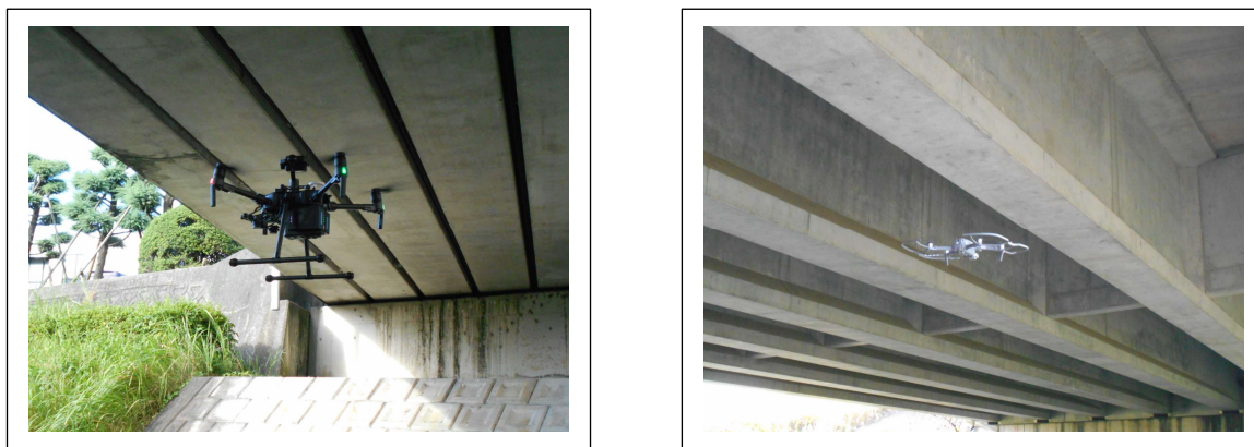
図-4.2 新技術を活用した点検事例
