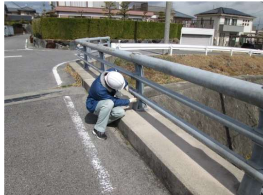
写真-4.2 職員による点検状況
