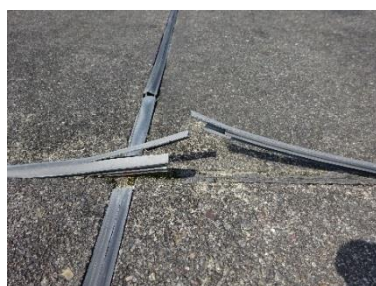
校舎屋上(音貝小学校)
