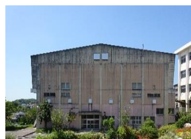
体育館外壁(東郷中学校)
