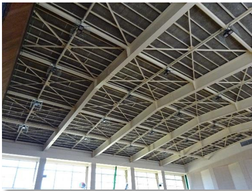
図 3-2 1 : 左 : 吊り天井対策完了の状況 (東郷小学校)
