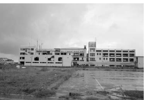
被災した陸前高田市役所
