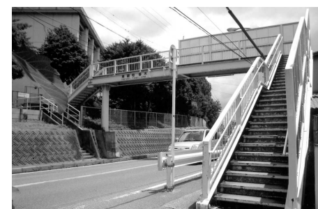
東郷小学校の歩道橋（昭和41年設置）
