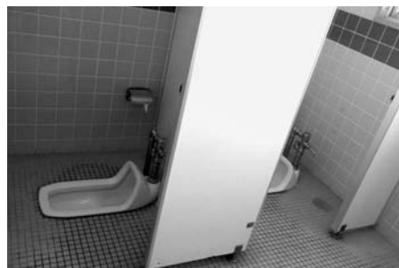
小学校の和式トイレ
