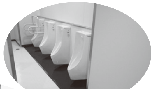
東郷中学校北校舎大規模改造工事 「トイレ洋式化」等
