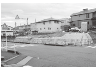
北山台の保育園建設現場
