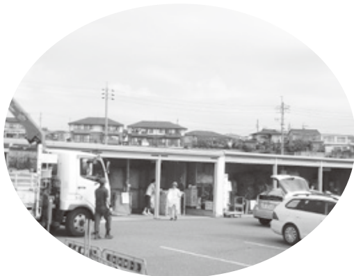
北部資源回収ステーション
