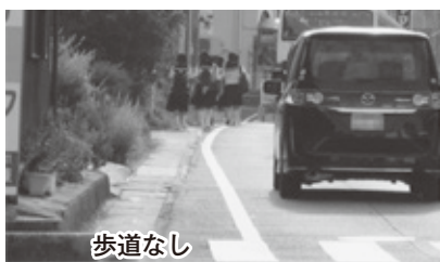
県道「和合交差点東側の歩道未整備区間」の現状
