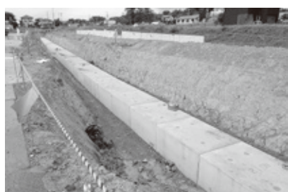
水路築造工事
