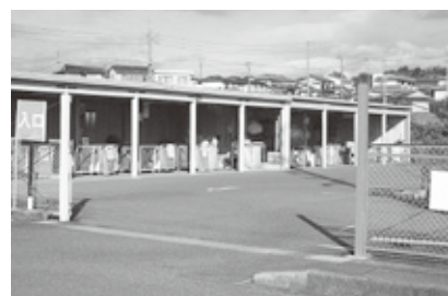
北部資源回収ステーション
