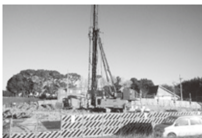
仮称新諸輪保育園の建設現場
