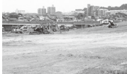
ららぽーと東郷 整地工事
