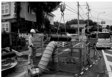
下水道工事の様子
