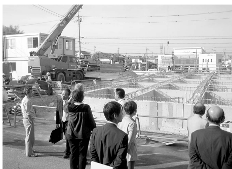
増築工事中の給食センター
