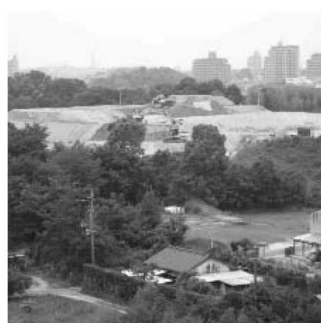
東郷町内でよく見られる盛土現場
