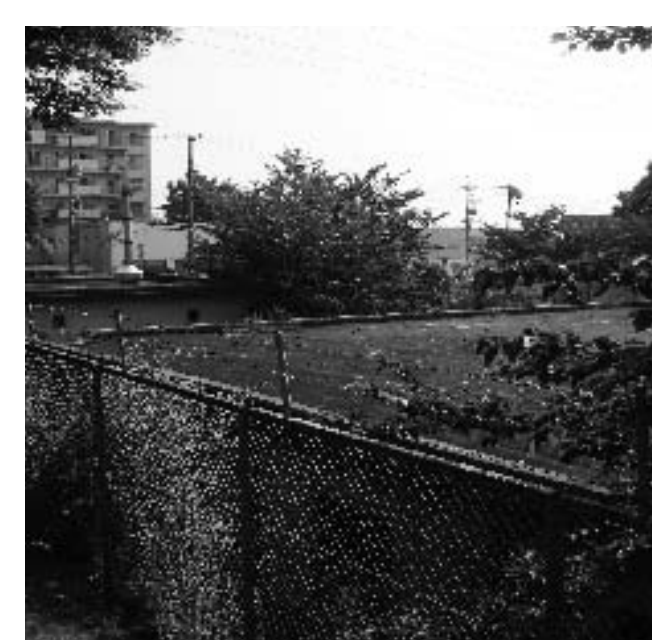
押草団地汚水処理場
