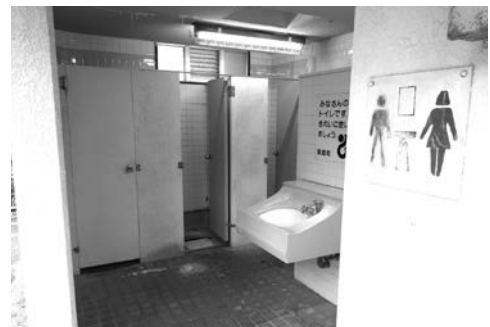
女性 男女共用の 和式便器しか 使えない 公園トイレ
