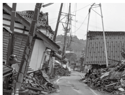
令和6年2月1日 石川県珠洲市宝立町 ((有) 工作舎中村建築 大工 中村武司氏撮影)
