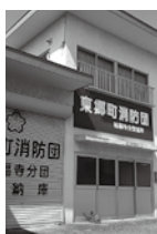
耐震性能を満たしていない消防団詰所
