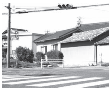
令和元年度諸輪交差点に設置された防護柵
