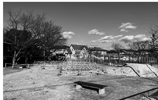
遊具の改修が進む町内の公園
