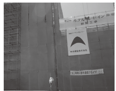
建設中の町内宿泊施設
