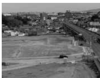
建設中の県道と「ららぽーと」
