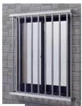
高強度の材質の物や、窓枠一体型の物もある。既存の格子は、ドライバーで外せないように、ネジ山をハンマー等で潰しておく
